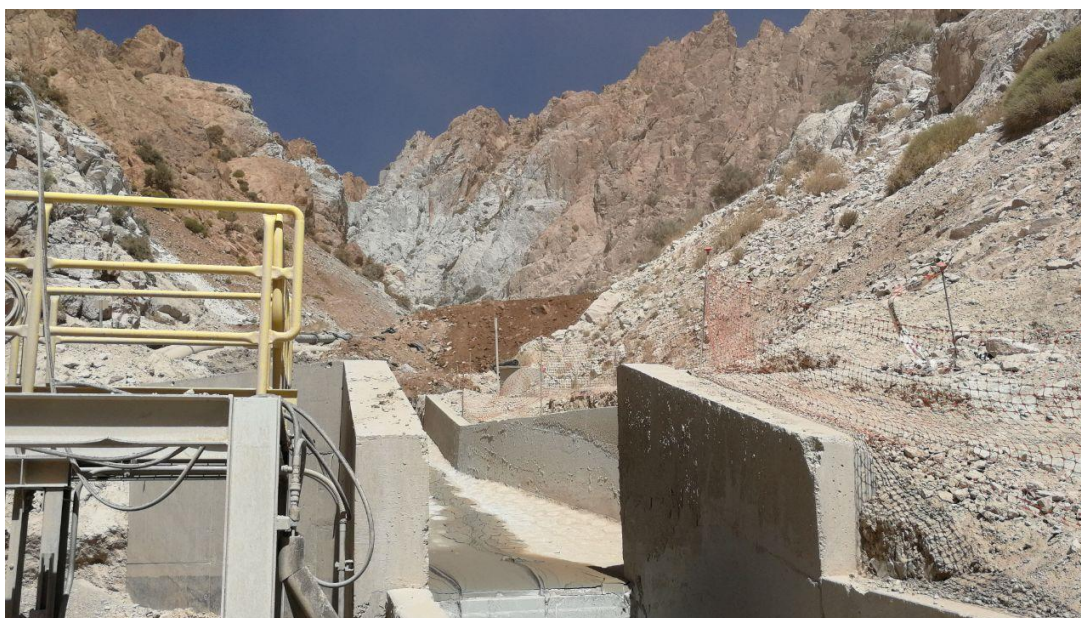
Figura 4: Pretil construido para contener derrame aguas arriba de interceptor IP-A2. Al centro se aprecia de color marrón el pretil instalado.
