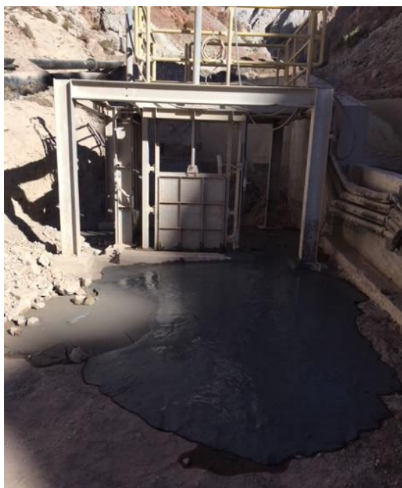
Figura 2: IP-A2. Se aprecia la compuerta abierta de la conducción que descarga en la cubeta de relaves junto al rebose producido.
