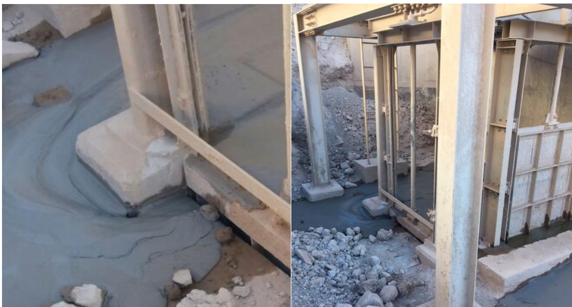
Figura 3: Ranura por la que el rebose ingresó al sistema de desvío de aguas naturales sur-oriente de la quebrada La Brea. En la fotografía de la derecha se aprecia la compuerta hacia la cubeta (abierta) y a la izquierda la compuerta hacia el sistema de desvío de aguas naturales (cerrada). En la fotografía de la izquierda se muestra un acercamiento del rebose que ingresó al sistema.
