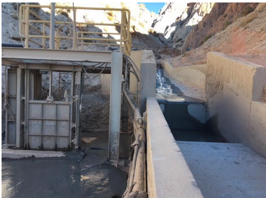
Figura 1: Vista hacia aguas arriba desde el interceptor IP-A2. A la derecha se aprecia el derrame bajando por la quebrada y a la izquierda el rebose existente.
